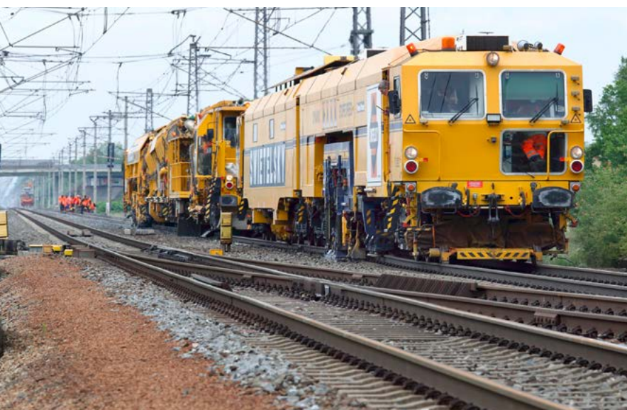
Tamping operations, Zábřeh na Moravě, Tschechien
